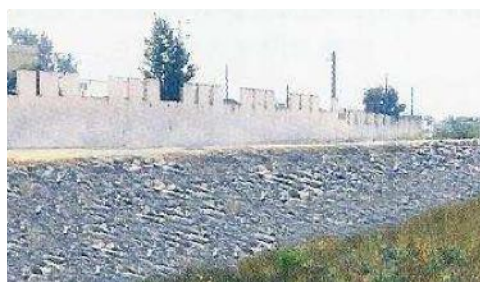
Digue de protection du Douar El Haj
