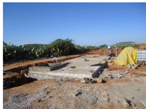
Travaux d'alimentation en eau potable
