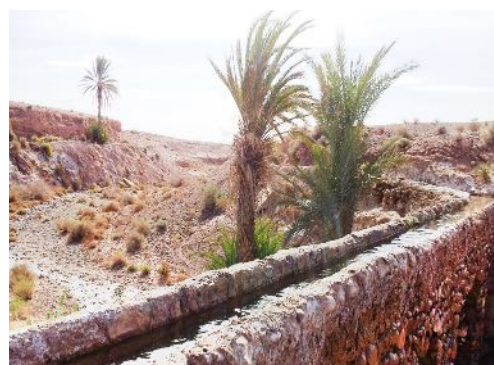
Seuil réalisé sur l'oued Ghmat (Nappe du Haouz Mejjate)
