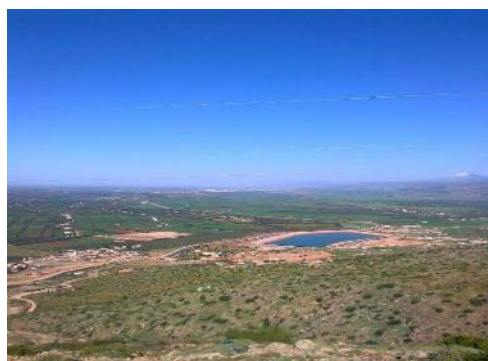
Bassin inférieur de la STEP d'Afourer
