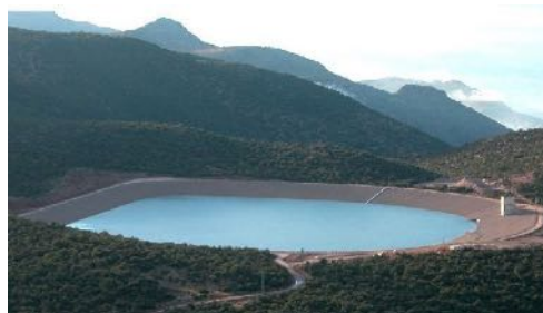
Bassin supérieur de la STEP d'Afourer
