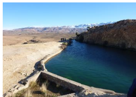
Bassin de mise en charge au niveau de la microcentrale de Fillo
