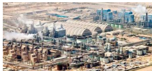
Station de dessalement de l'eau de Jorf Lasfar
