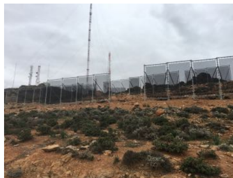
Unités de collecte de brouillard CloudFisher® de Aqualonis sur le Jbel Boutmezguida
