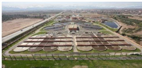
Station d'épuration des eaux usées de Marrakech
