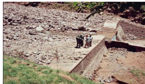
Aménagement d'un seuil
